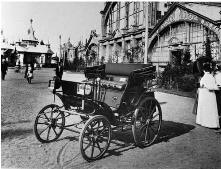
рессоры поворачивались вместе с колёсами относительно шкворней, причём шкворни П.А. Фрезе предусмотрел не только в балке передней оси, но и в расположенной над ней поперечине, жёстко связанной с каркасом кузова. На ней же крепилась рулевая трапеция, высоко поднятая над дорогой и таким образом не подверженная ударам о возможные препятствия.
